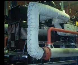
Jeder Wärmeverlust geht auch zu Lasten der **Effizienz**, sofern man die Motor - Abwärme verwenden möchte. Schon eine relativ dünne Motor Dämmung sorgt für deutlich höhere Temperaturen im Abgaswärmetauscher.
